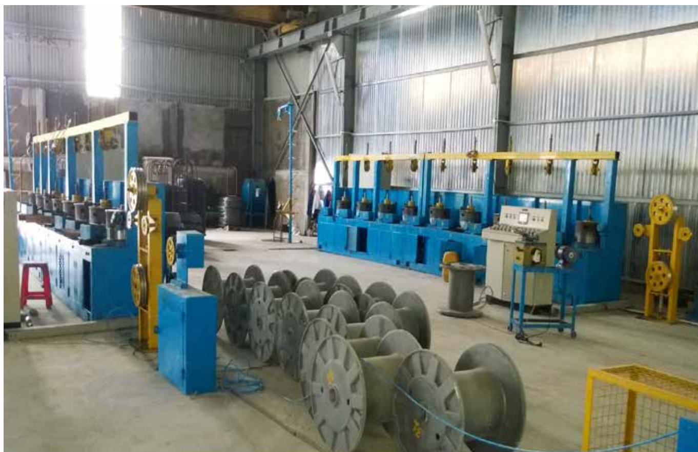
Biến tần CHV100: Tủ biến tần cho máy kéo kẽm tốc độ cao tại nhà máy Việt Quang - Quảng Ngãi
