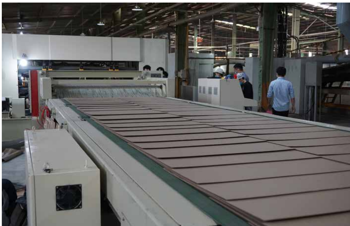
Biến tần GD35-09: Tủ điều khiển máy cắt dao quay cắt theo vạch màu - Công ty Tân Thành Đồng
