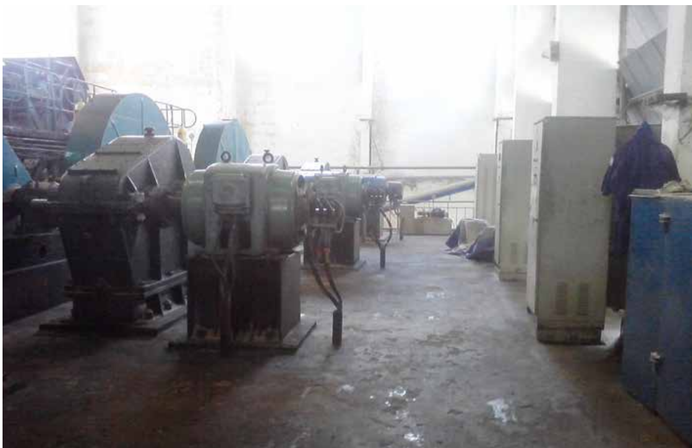
Biến tần INVT và RBU: Máy ly tâm đường tại Nhà máy đường Biên Hòa thuộc Tập đoàn TTC
