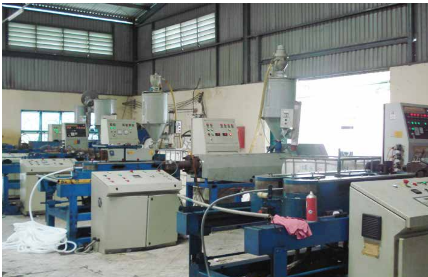
Biến tần CHF100A: Điều khiển hệ thống máy làm ruột gà
