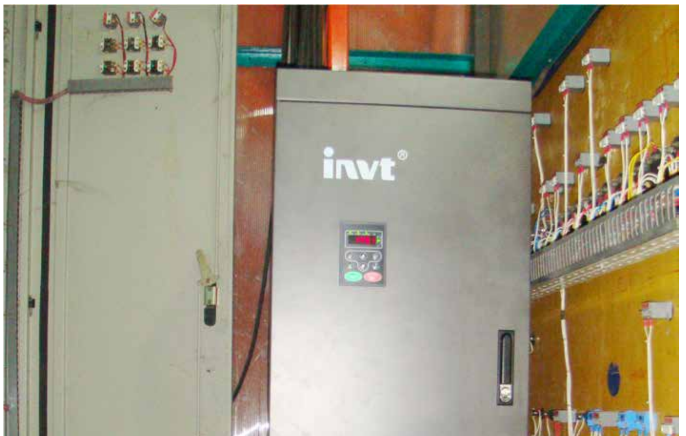
Biến tần CHF100A (132 kW): Điều khiển máy nghiền thủy lực - Ngành giấy
