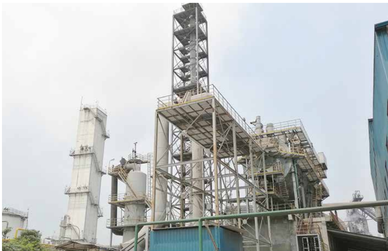
Biến tần trung thế GD5000: Biến tần trung thế INVT cho Quạt thu hồi khí tại Công ty Thép Hòa Phát - Hải Dương
